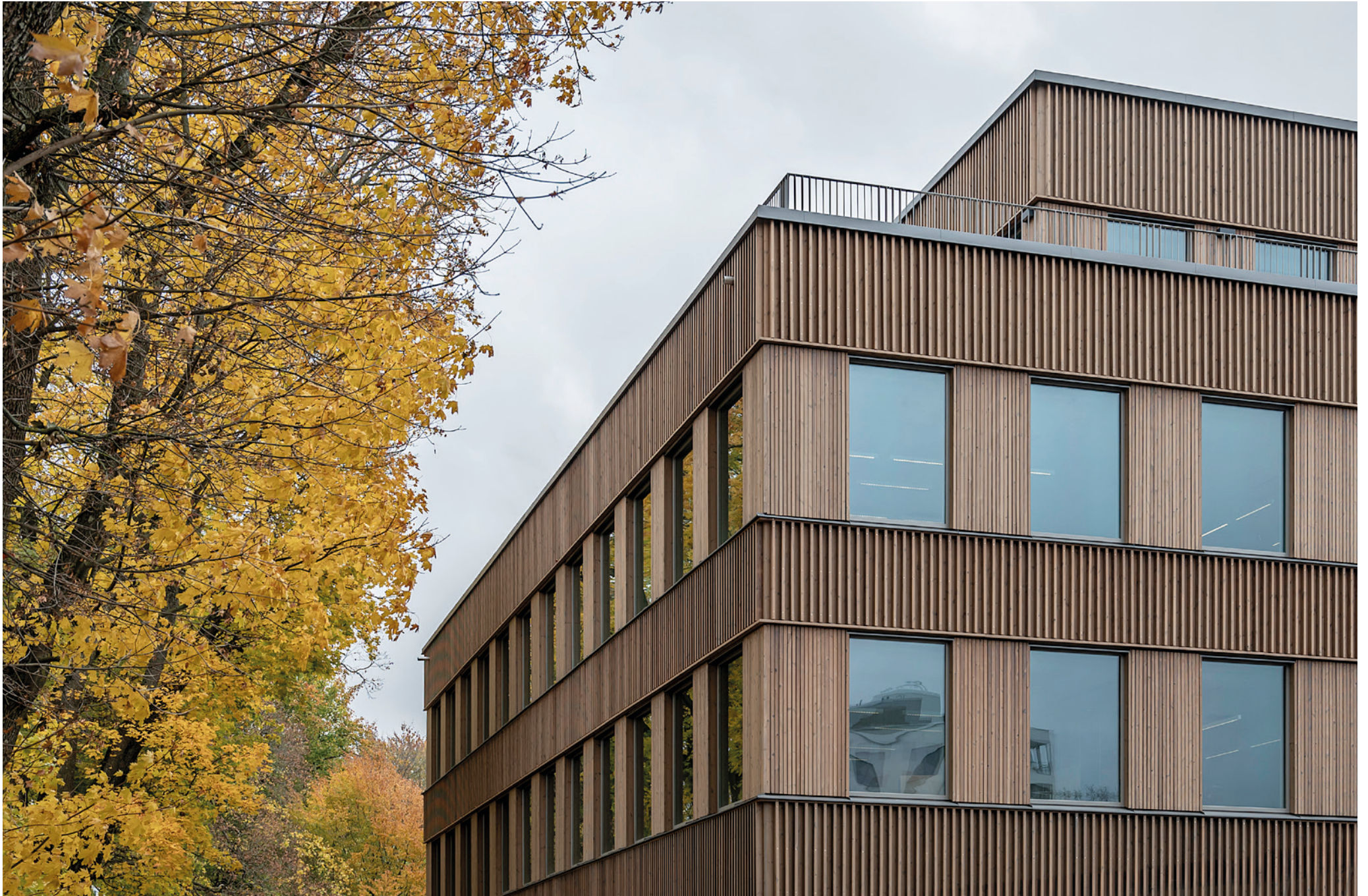
Enköpings kommunhus, 2025. C.F. Møller Architects
