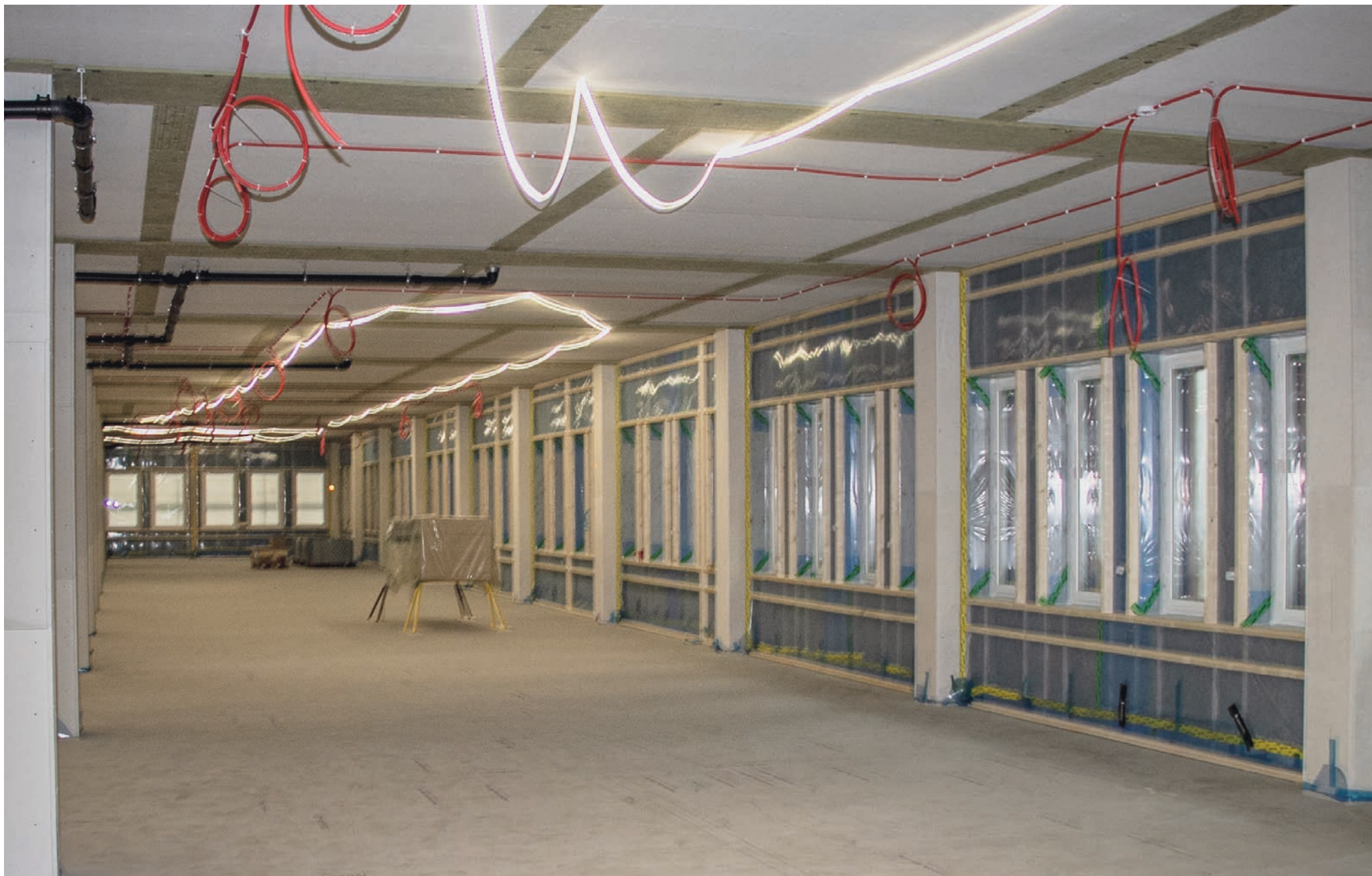
Nya Centralsjukhuset i Karlstad, work-in-progress-bild, 2025. Foto: Magnus Falk
